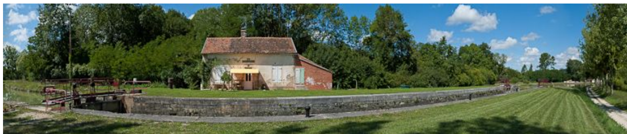
Vue d'ensemble du site d'écluse.
