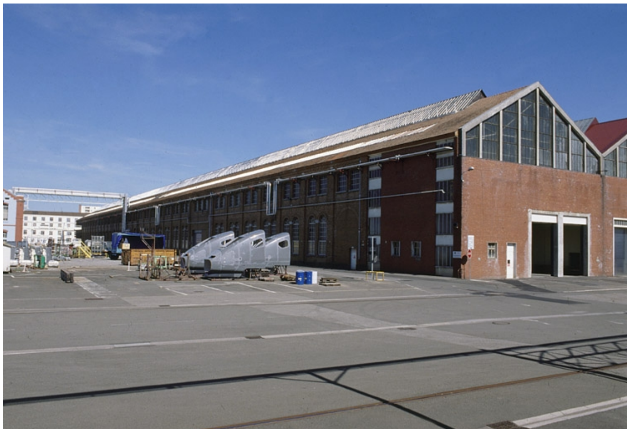
Façade nord de l'atelier Traction.
