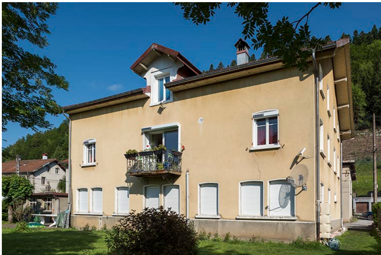
Fonderie : façade postérieure, de trois quarts droite.
