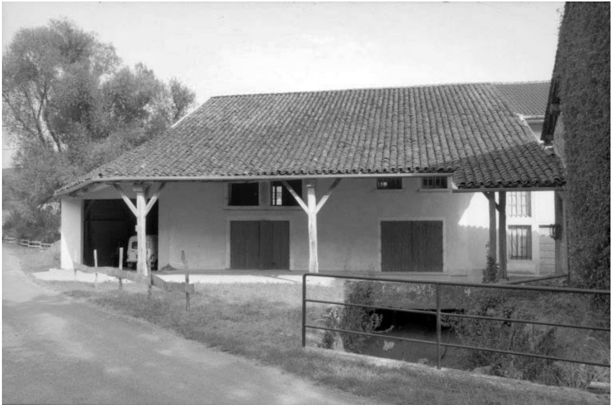
Canal d'amenée et auvent.
