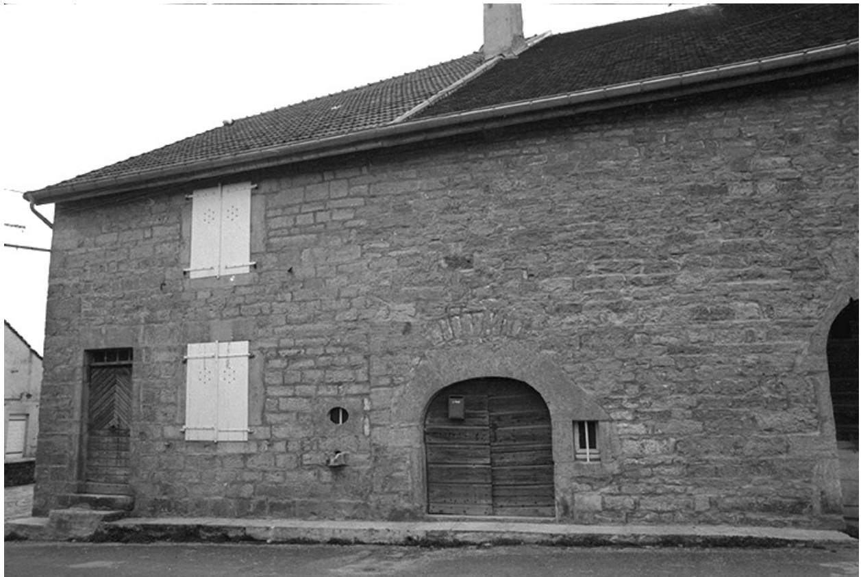
Ferme cadastrée 1965 AB 249 et 252 : façade antérieure.
