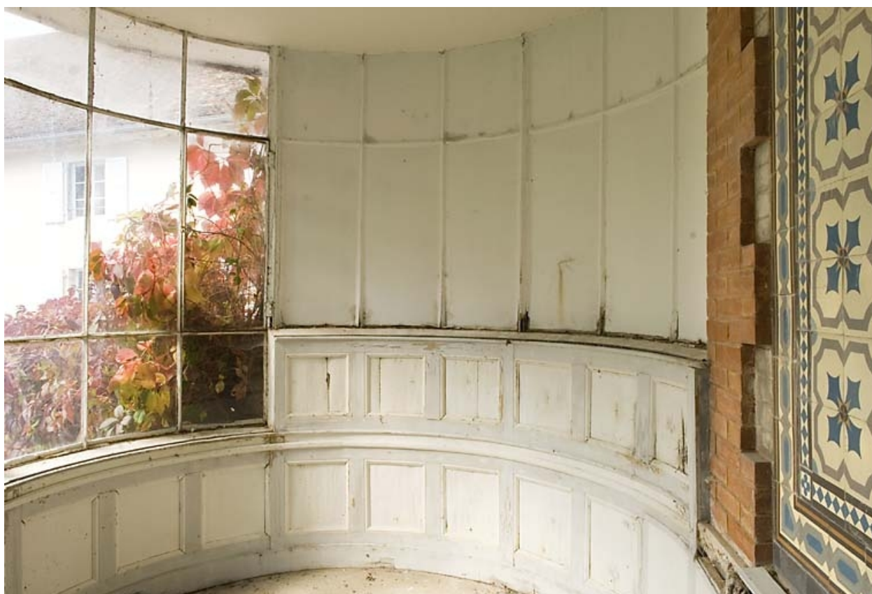
Serre : intérieur (extrémité nord-ouest).
