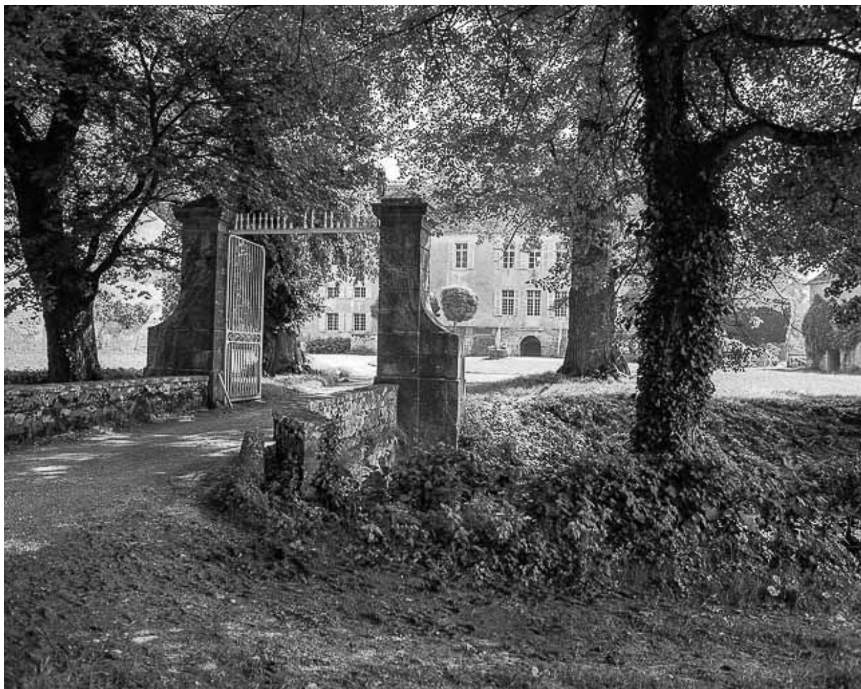
Façade antérieure avec entrée.
