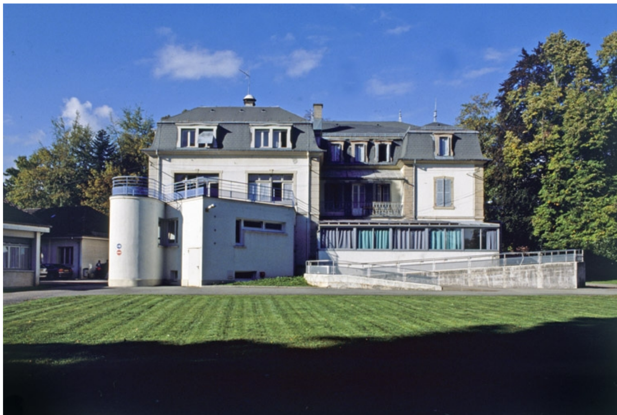
Façade postérieure du logement patronal.
