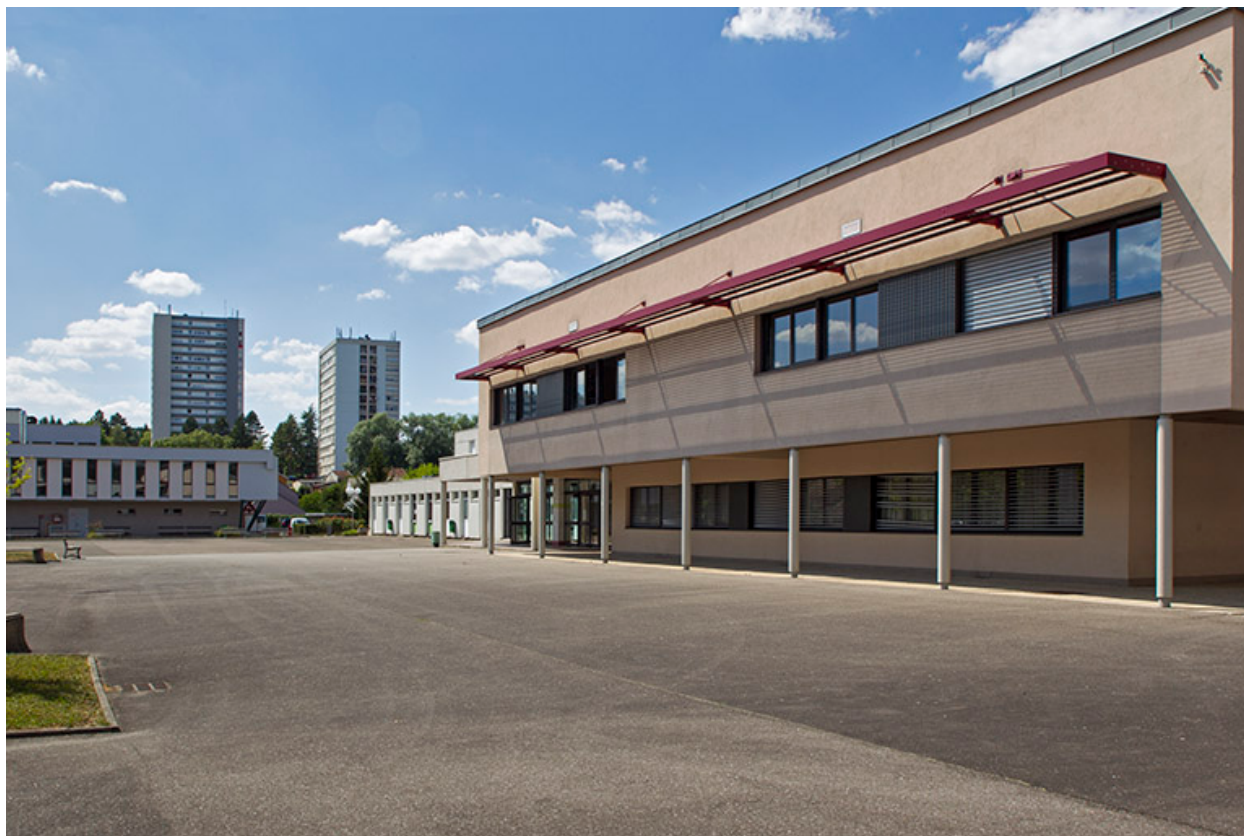
La cour vue de l'est.
