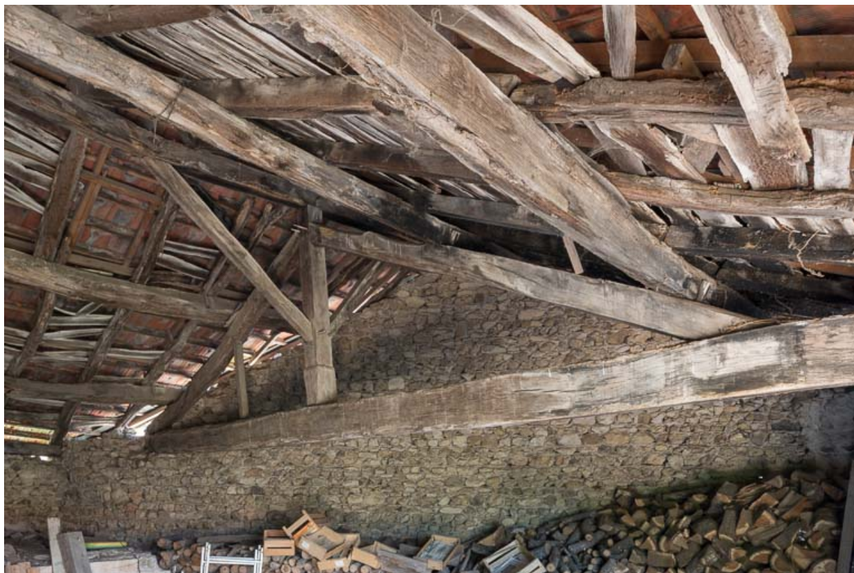
Charpente du cuvage
