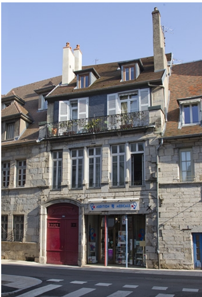
Vue d'ensemble depuis la rue.
