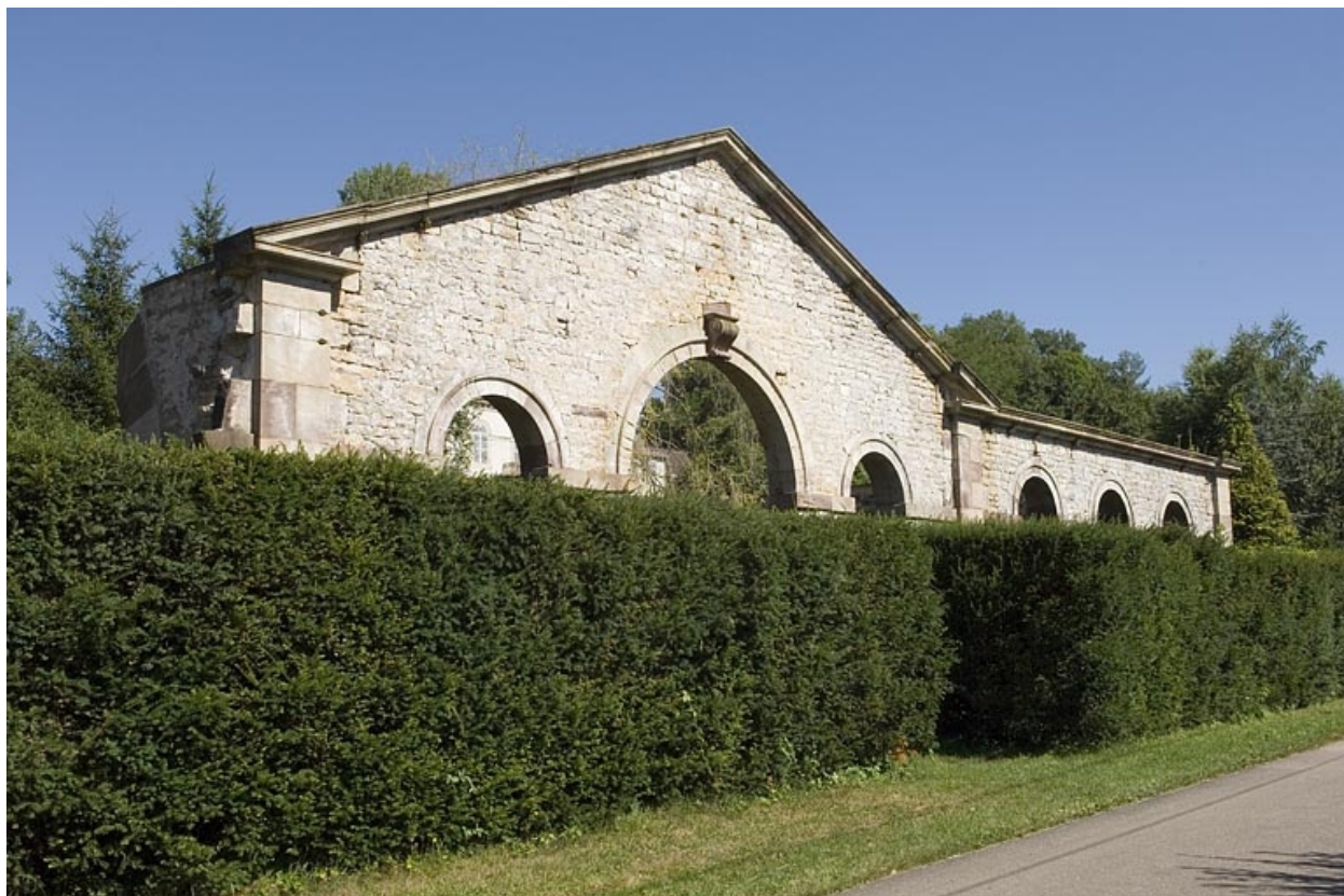
Façade antérieure de l'atelier du haut fourneau.
