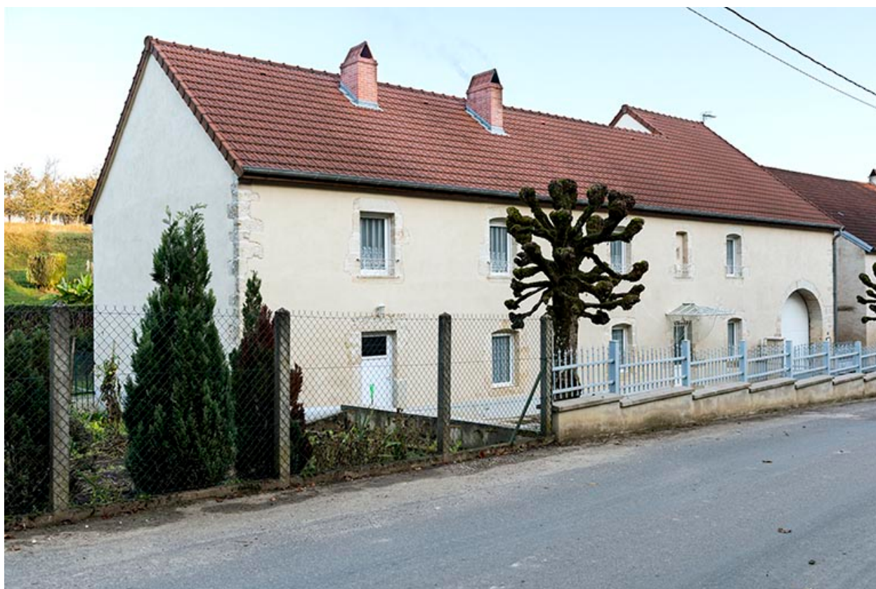
Ferme-bloc, 10-14 rue de la Garenne.
