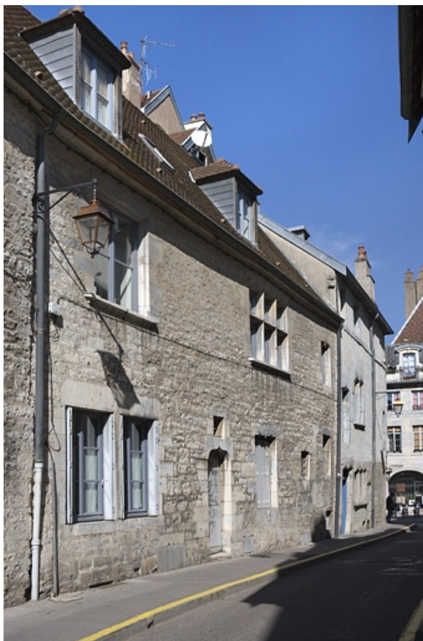
Façade latérale gauche, vue partielle.
