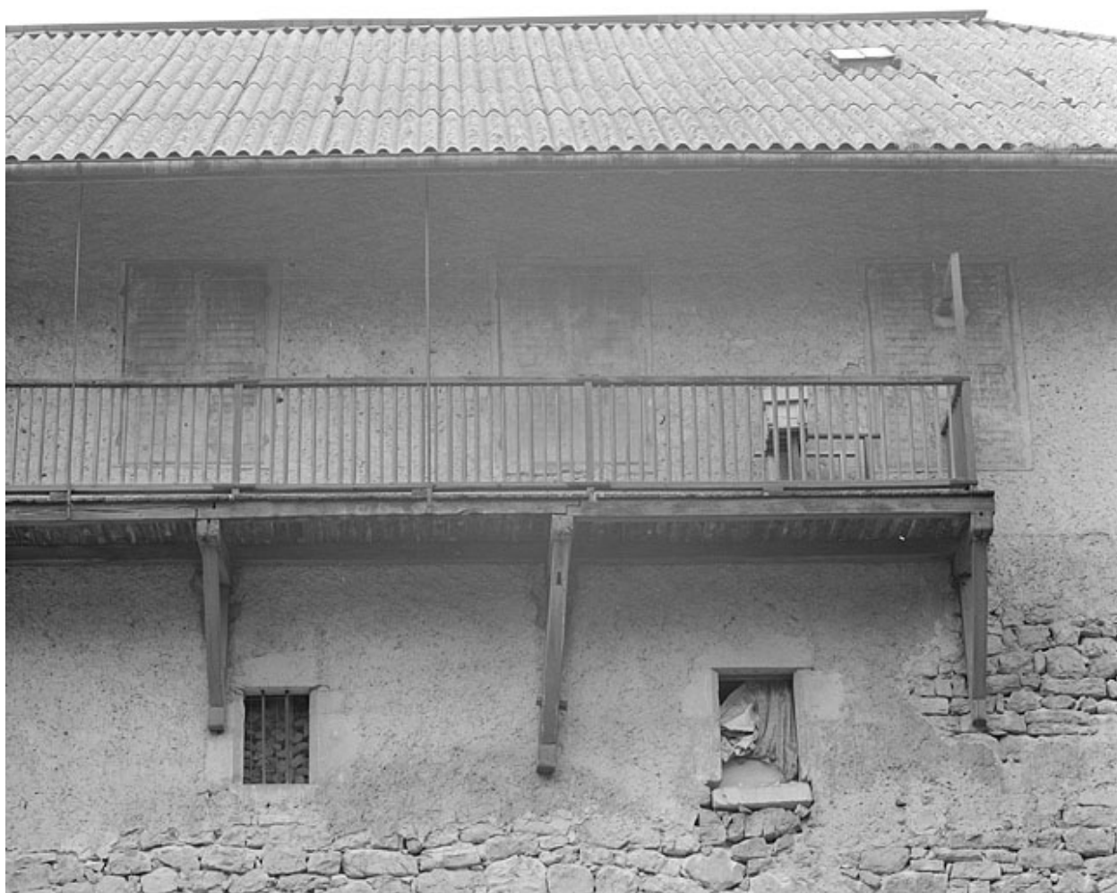
Détail de la façade postérieure.
