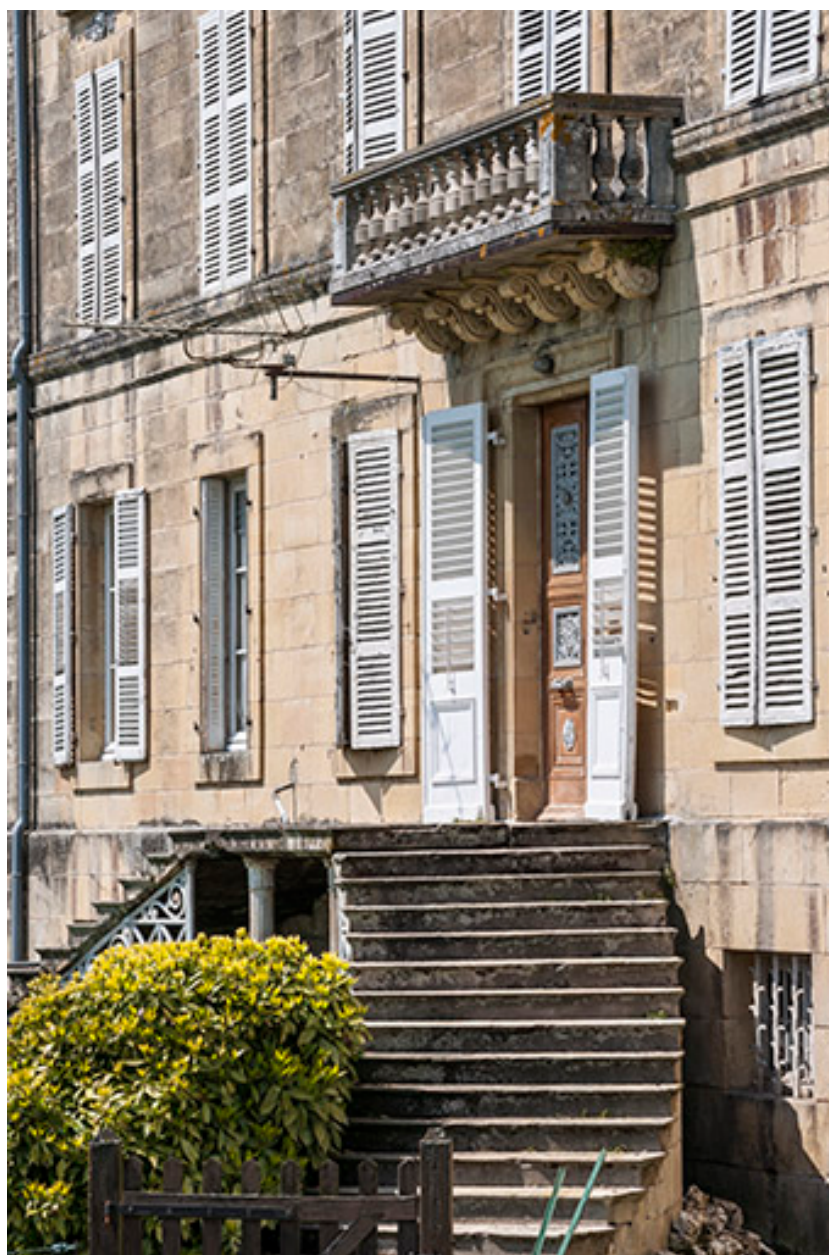
Vue de trois-quarts de la travée centrale, façade sud.
