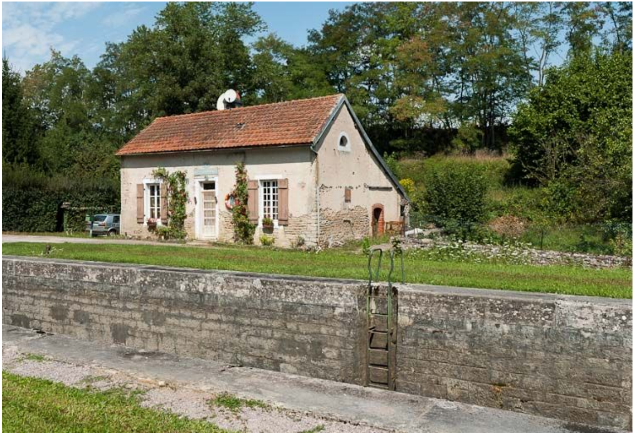
Vue de 3/4 de la maison éclusière.
