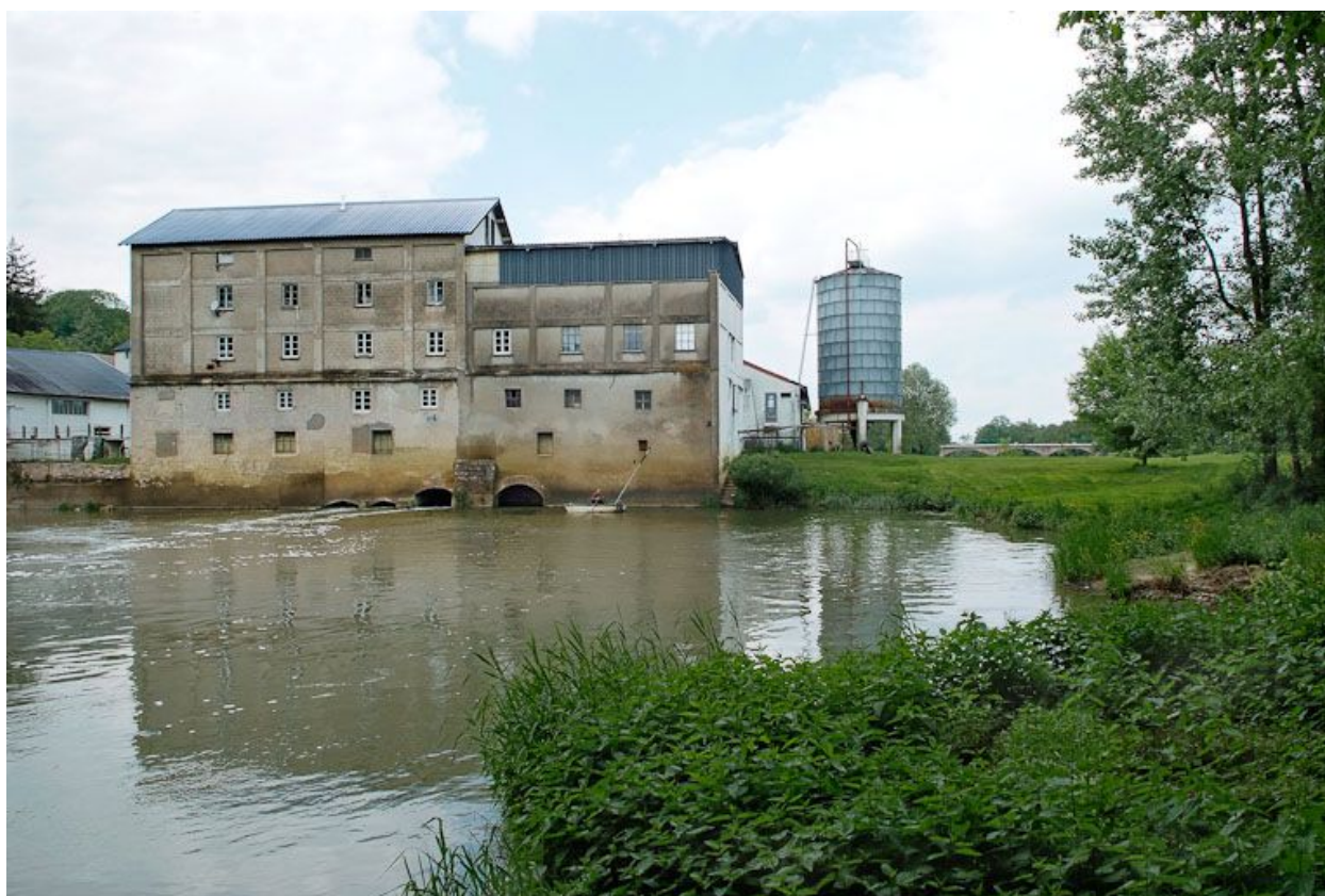
Le moulin vu d'aval.
