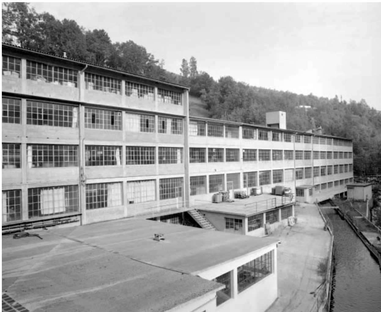
Façade postérieure des ateliers de fabrication.
