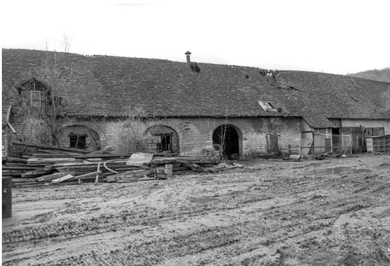
Bâtiments industriels sur l'île en 1979.
