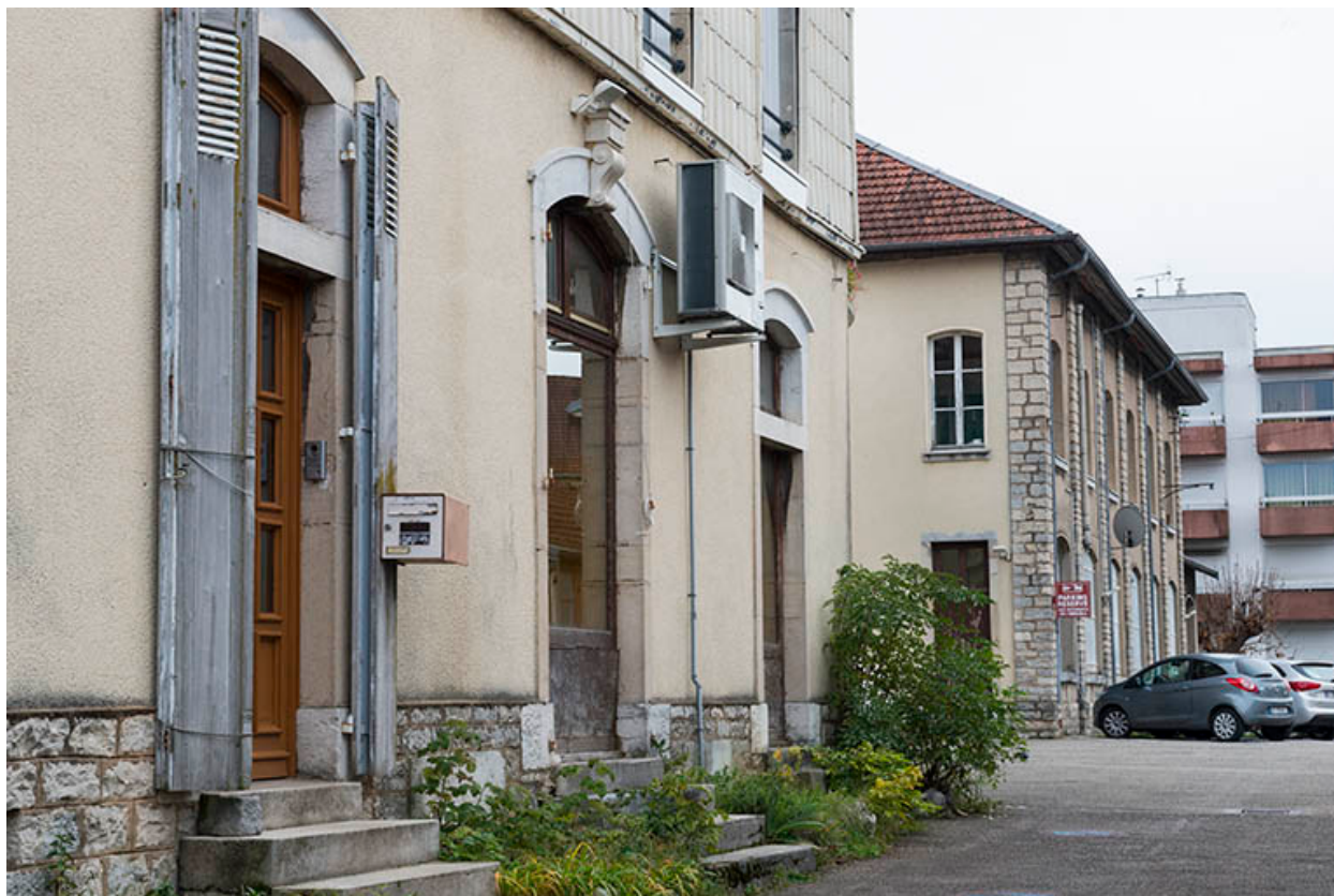
Vue depuis l'entrée. Logement et atelier.
