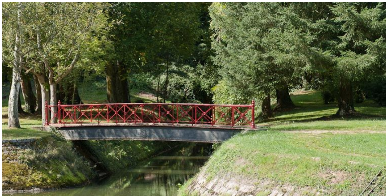
Vue d'un pont sur rigole.
