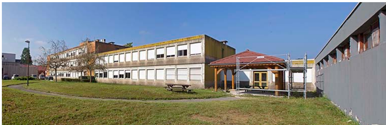
Externat : façade postérieure.
