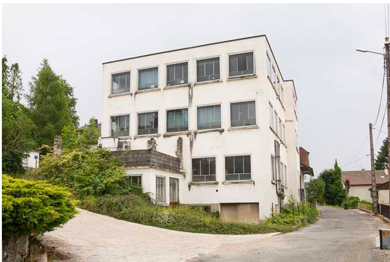
Atelier de fabrication des années 1980.
