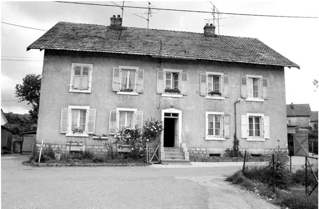
Maison ouvrière à quatre logements en 1980.
