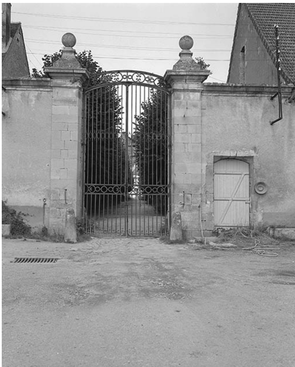
Grille d'entrée de la cour des communs.
