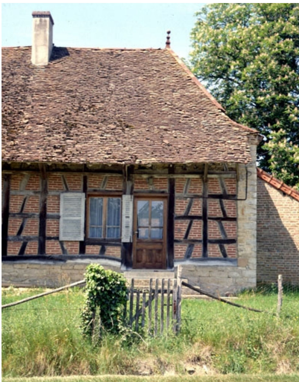
Bâtiment d'habitation en 1990 : partie droite.
