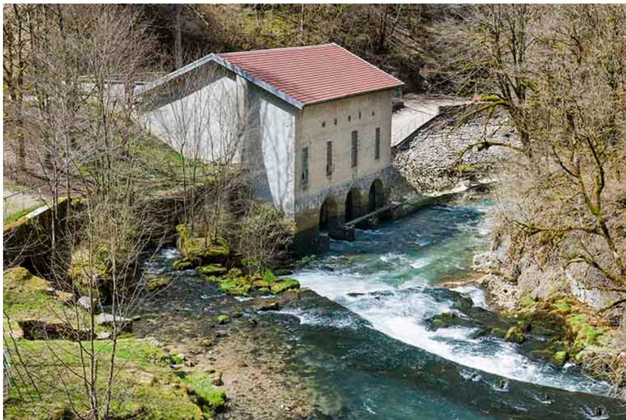
La centrale hydroélectrique depuis l'amont.
