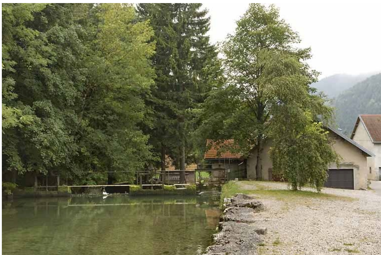
Canal d'amenée, depuis l'amont.
