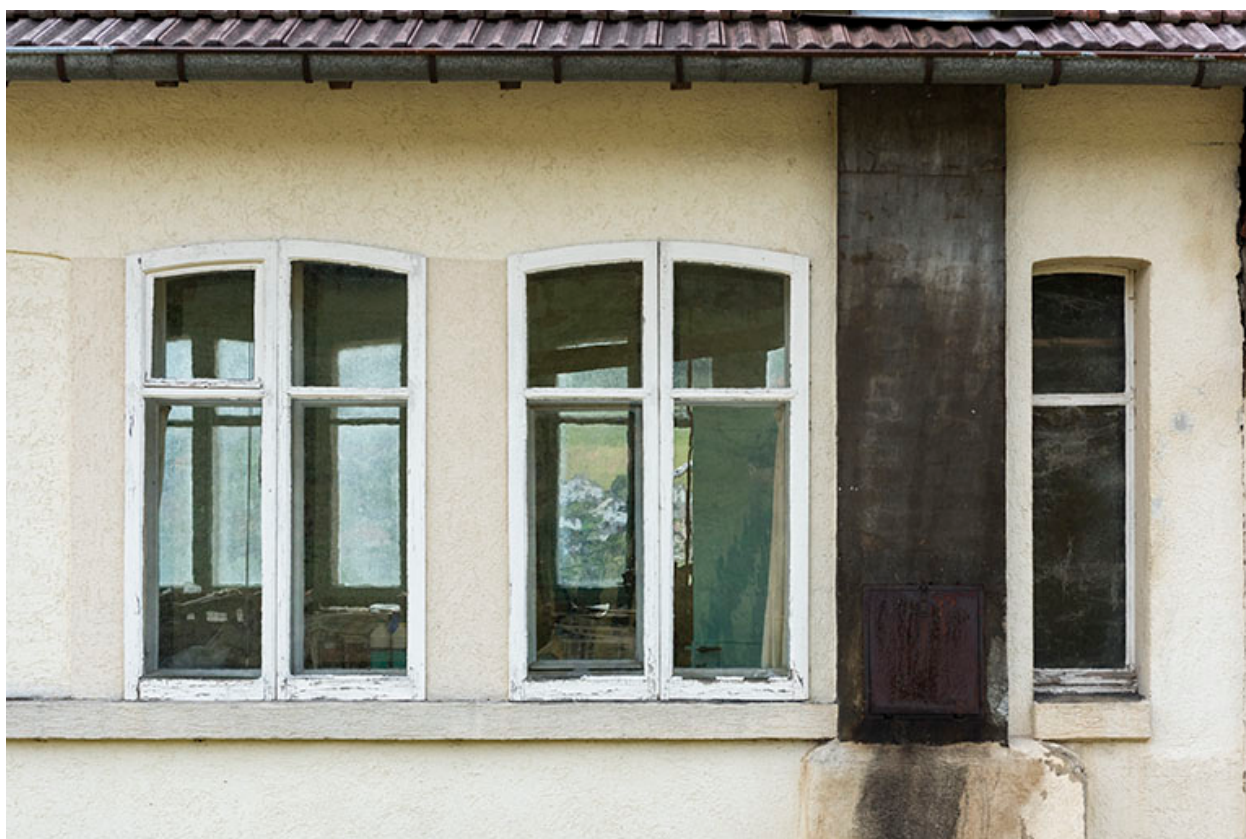
Atelier de fabrication : fenêtre horlogère au nord.
