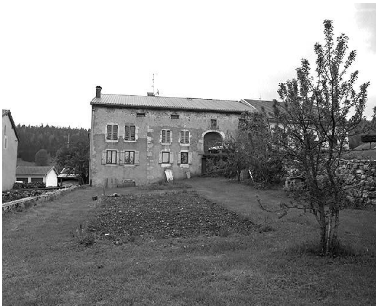
Façade postérieure, vue éloignée.
