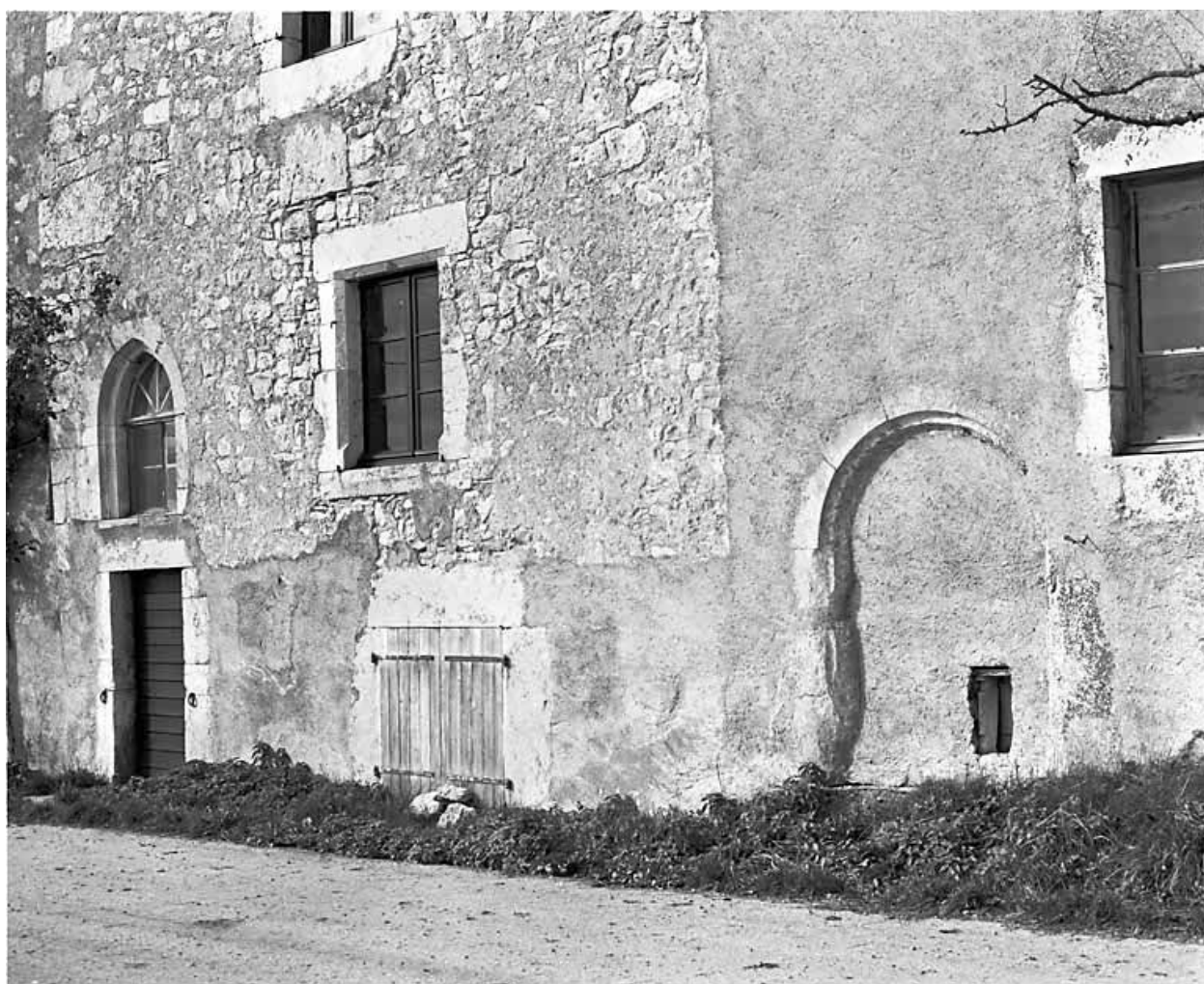
Façade sur rue, partie centrale.
