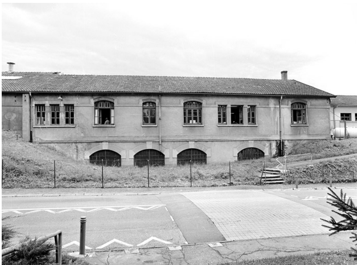
Façade postérieure des ateliers de fabrication.
