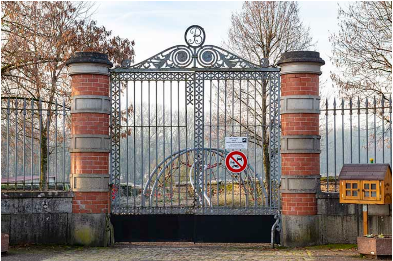
Clôture (grille) sur l'avenue des Pâtis.
