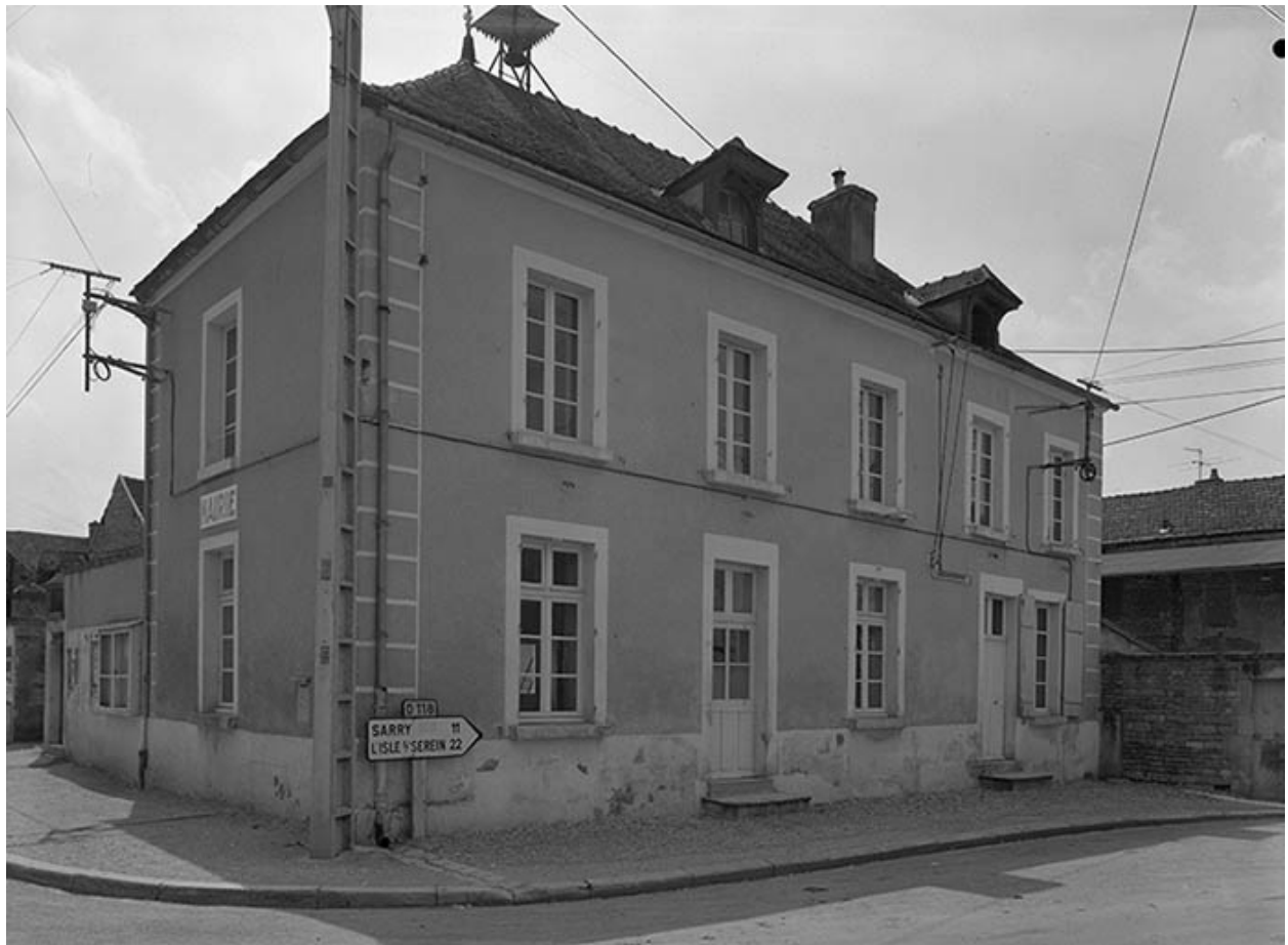
Façades sur la Grande-Rue et de la rue du Four.
