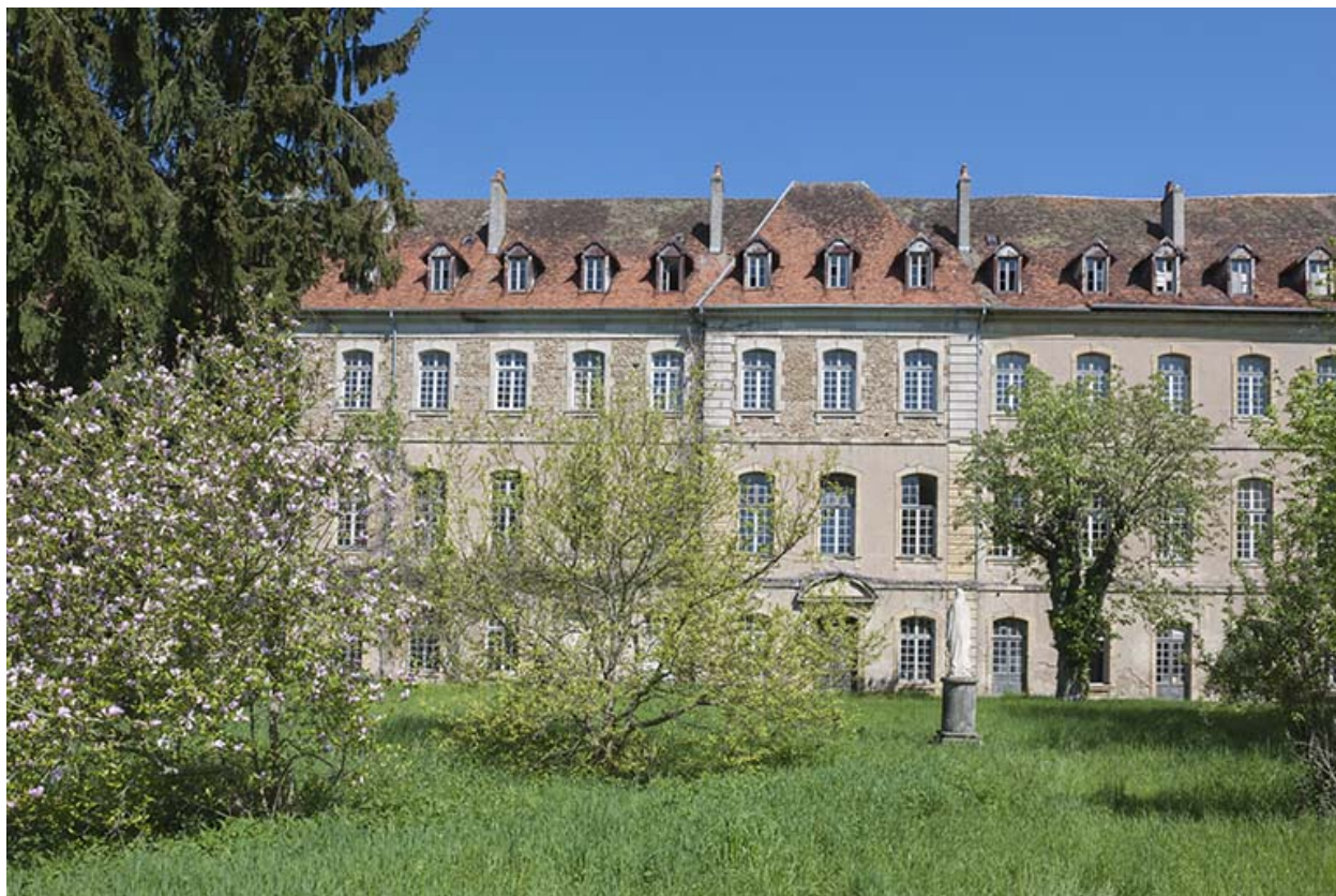
Façade sud vue de face.
