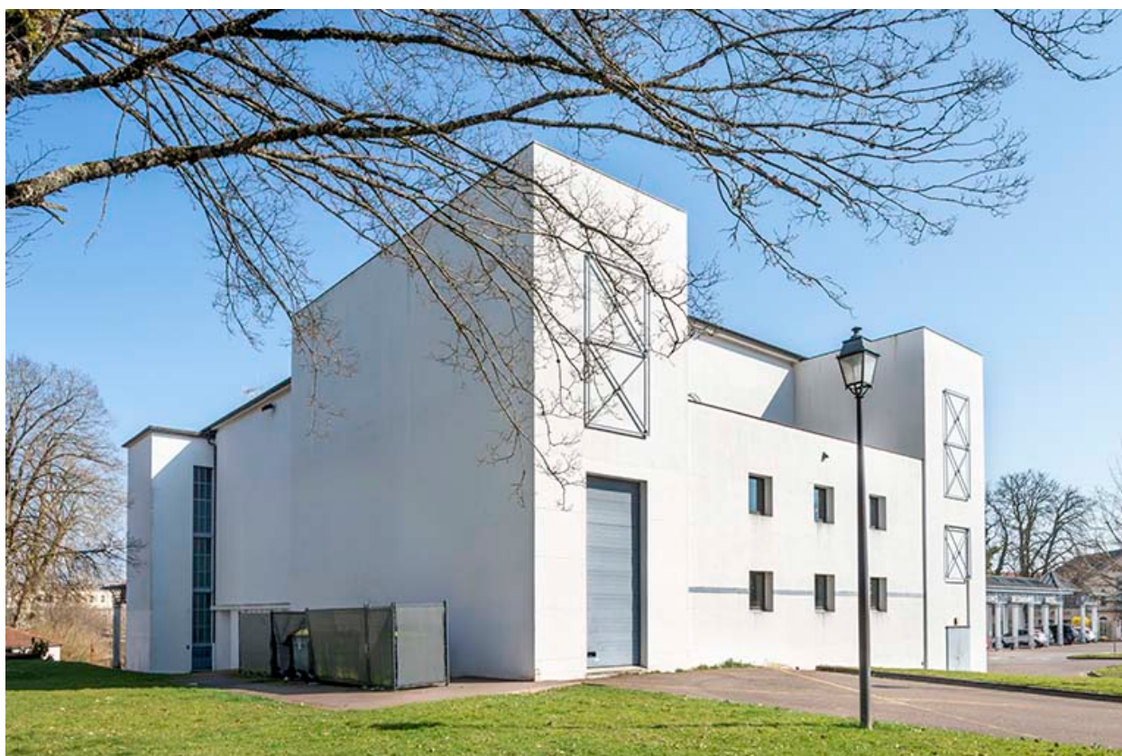
Salle des fêtes, vue depuis le nord-ouest.
