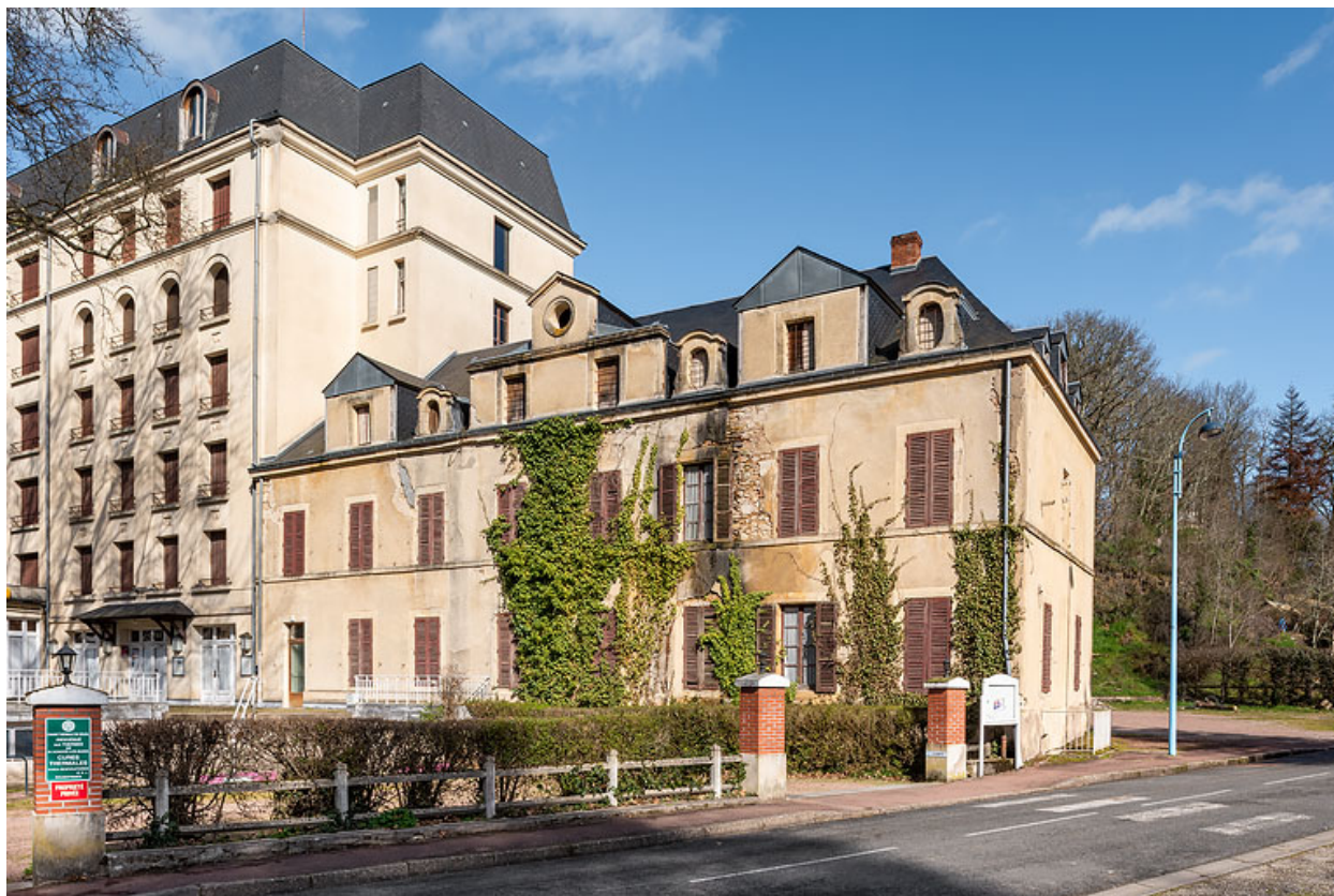
Façade principale, vue depuis le sud-ouest.
