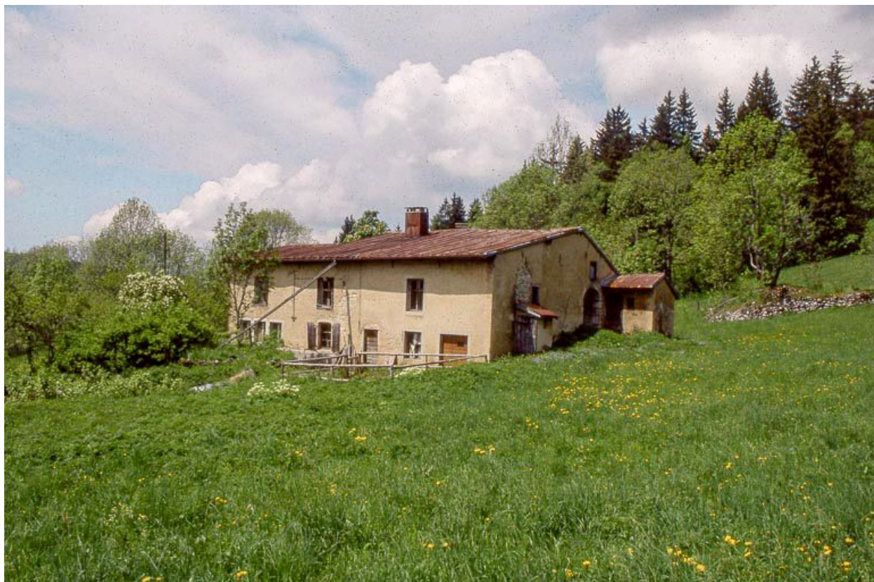
Vue éloignée de la façade antérieure.
