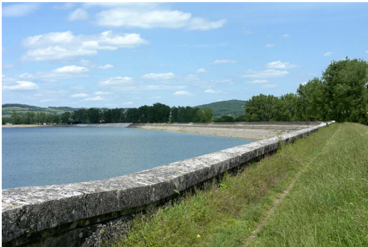
Digue est, vue d'ensemble.
