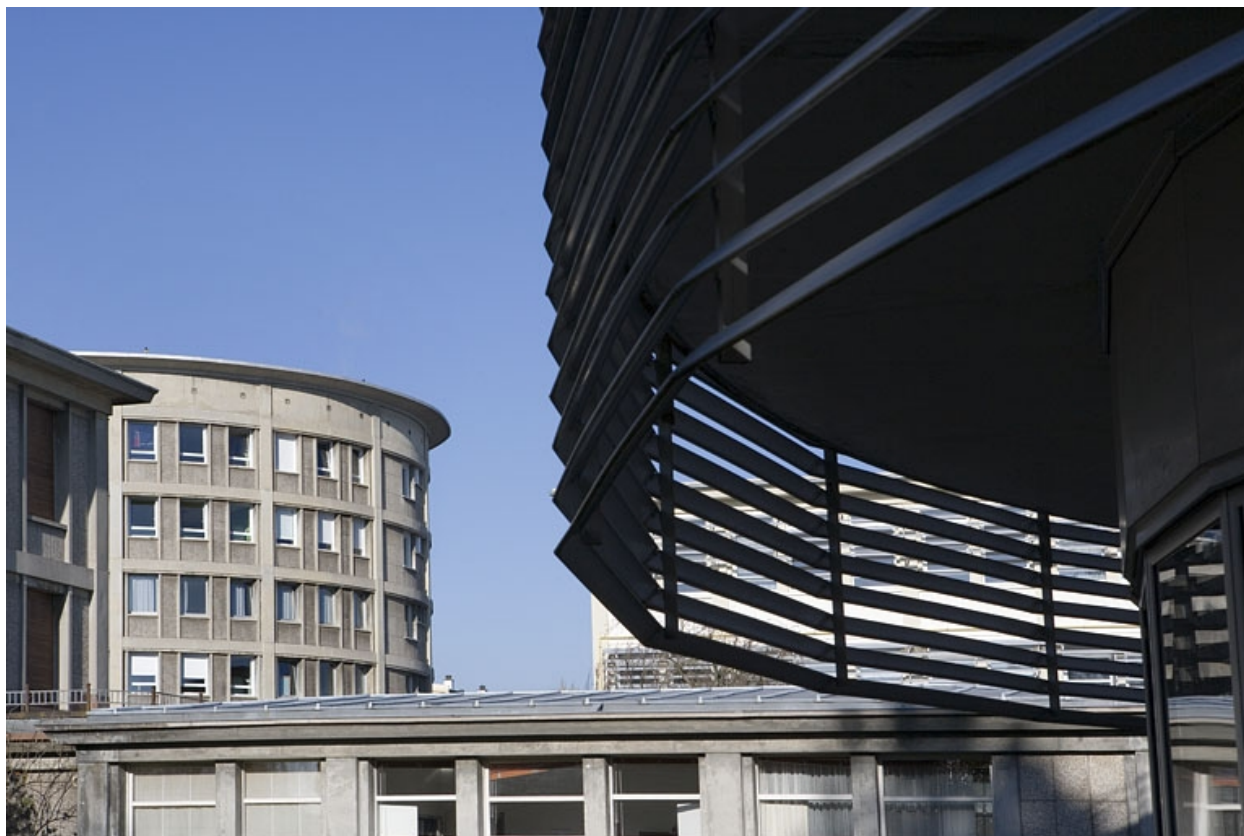
Détail architecture aile gauche bâtiment L.
