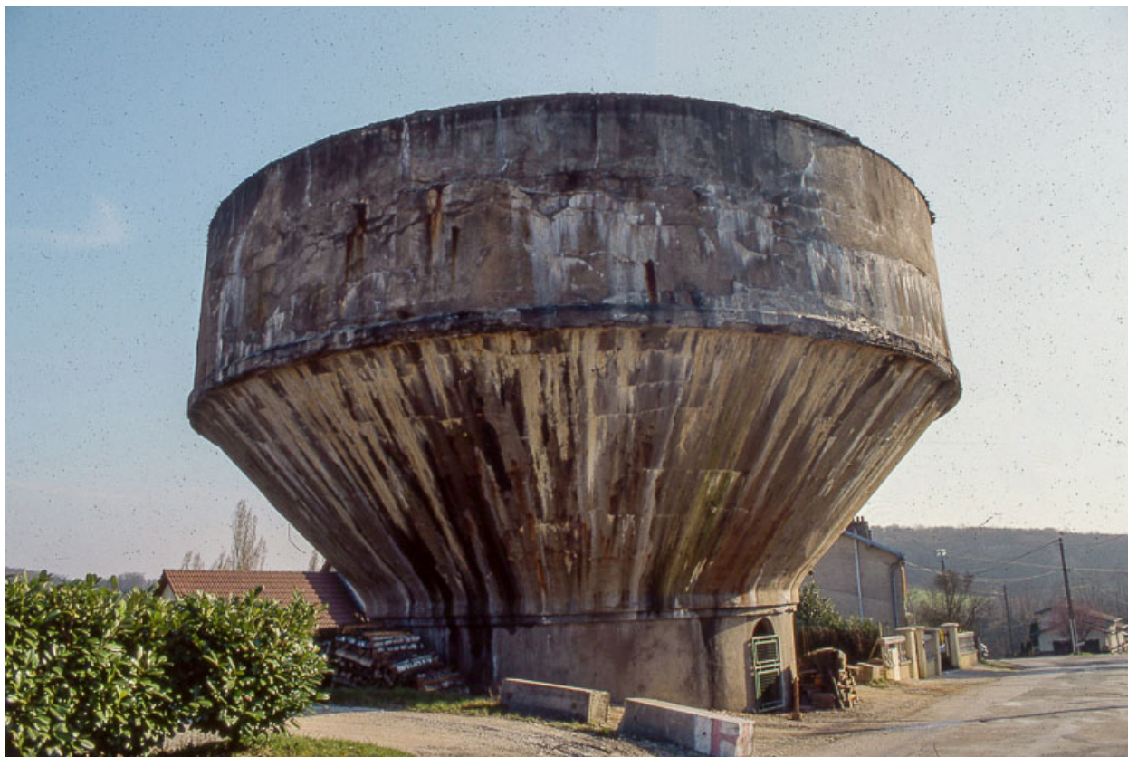
Réservoir industriel (depuis le nord).
