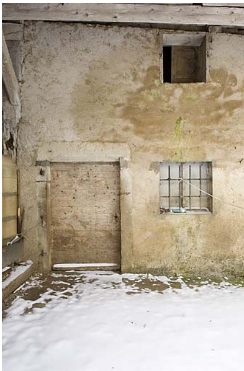
Façade postérieure : porte.
