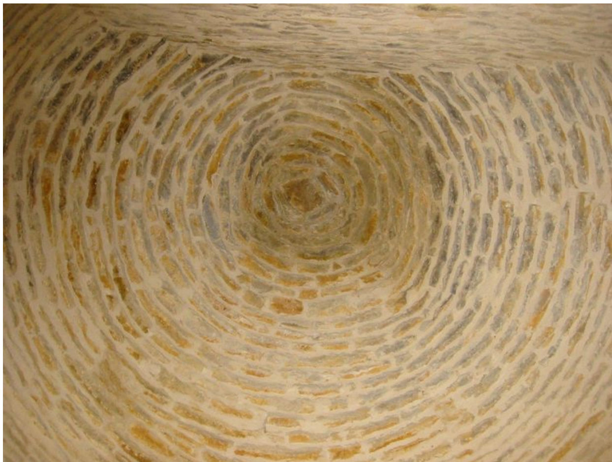
Vue de la voûte supportant la toiture en laves.
