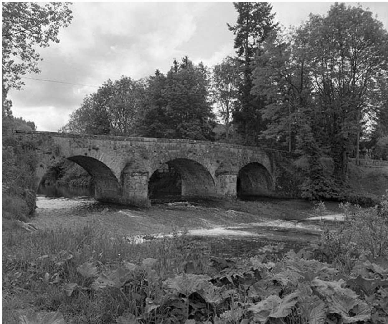
Face aval, vue de trois quarts
