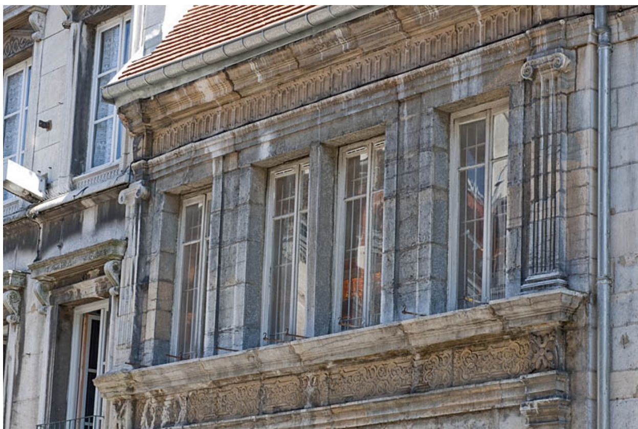
Façade sur rue : premier étage, partie gauche.
