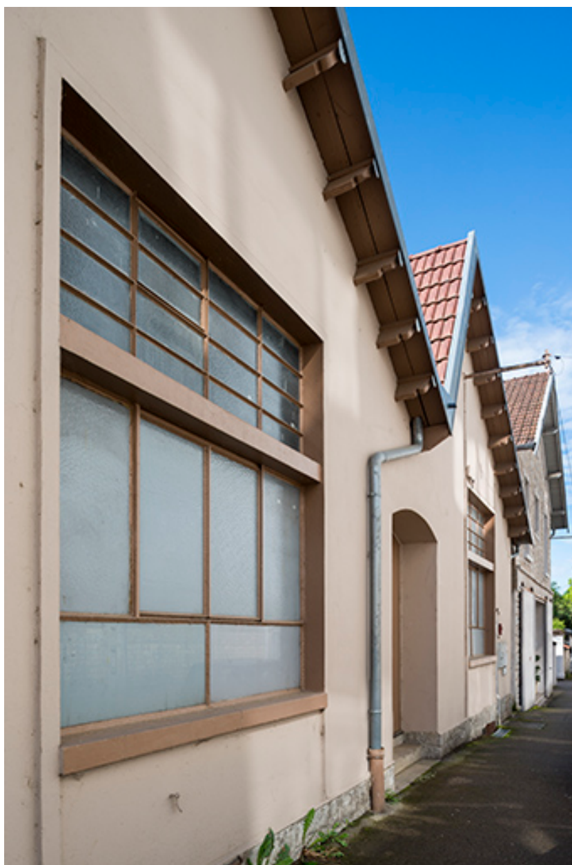
Détai des murs-pignons des sheds.
