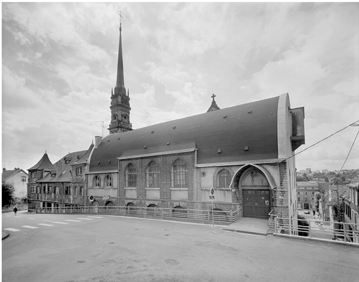
Vue d'ensemble du gymnase.
