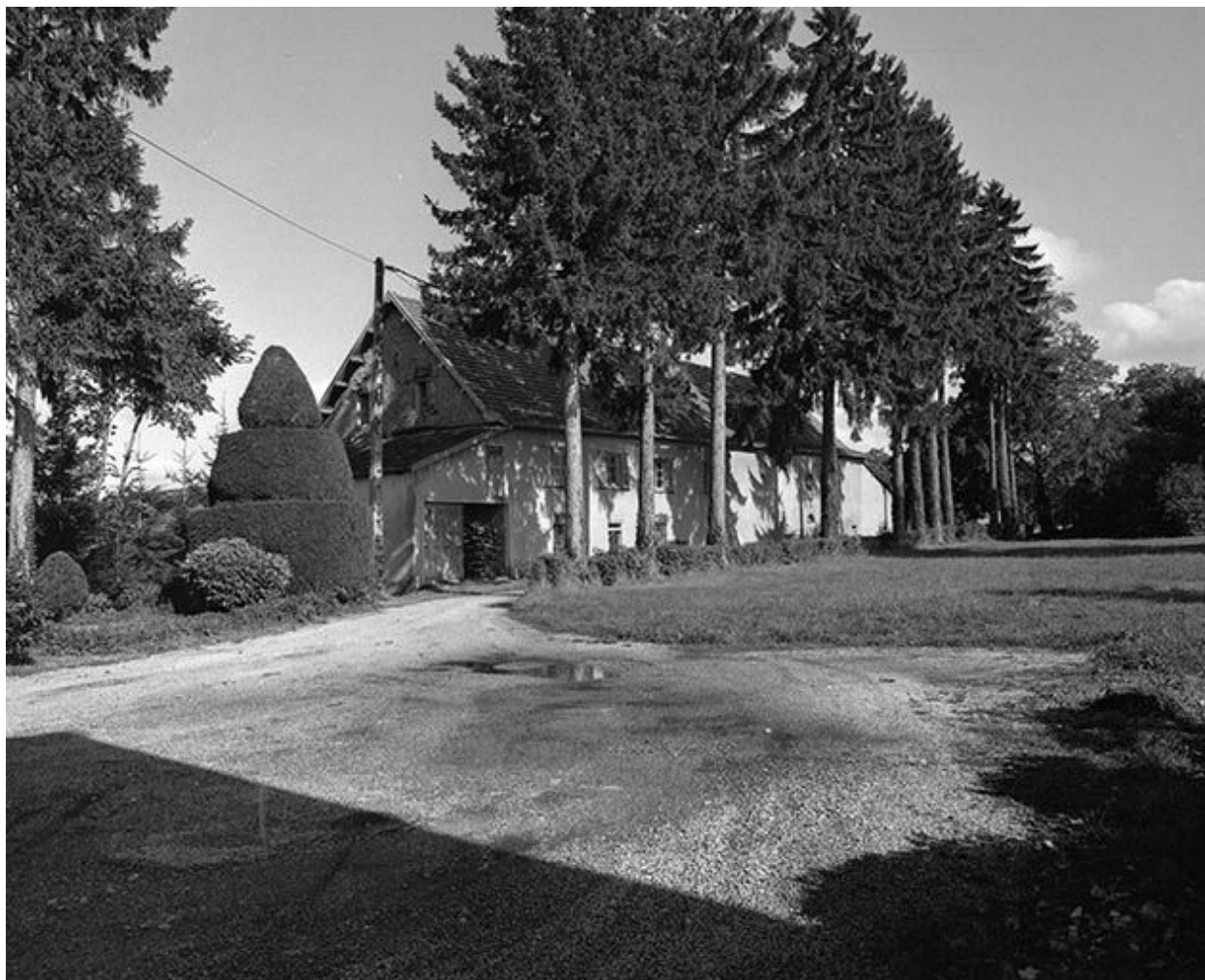
Vue générale des communs.
