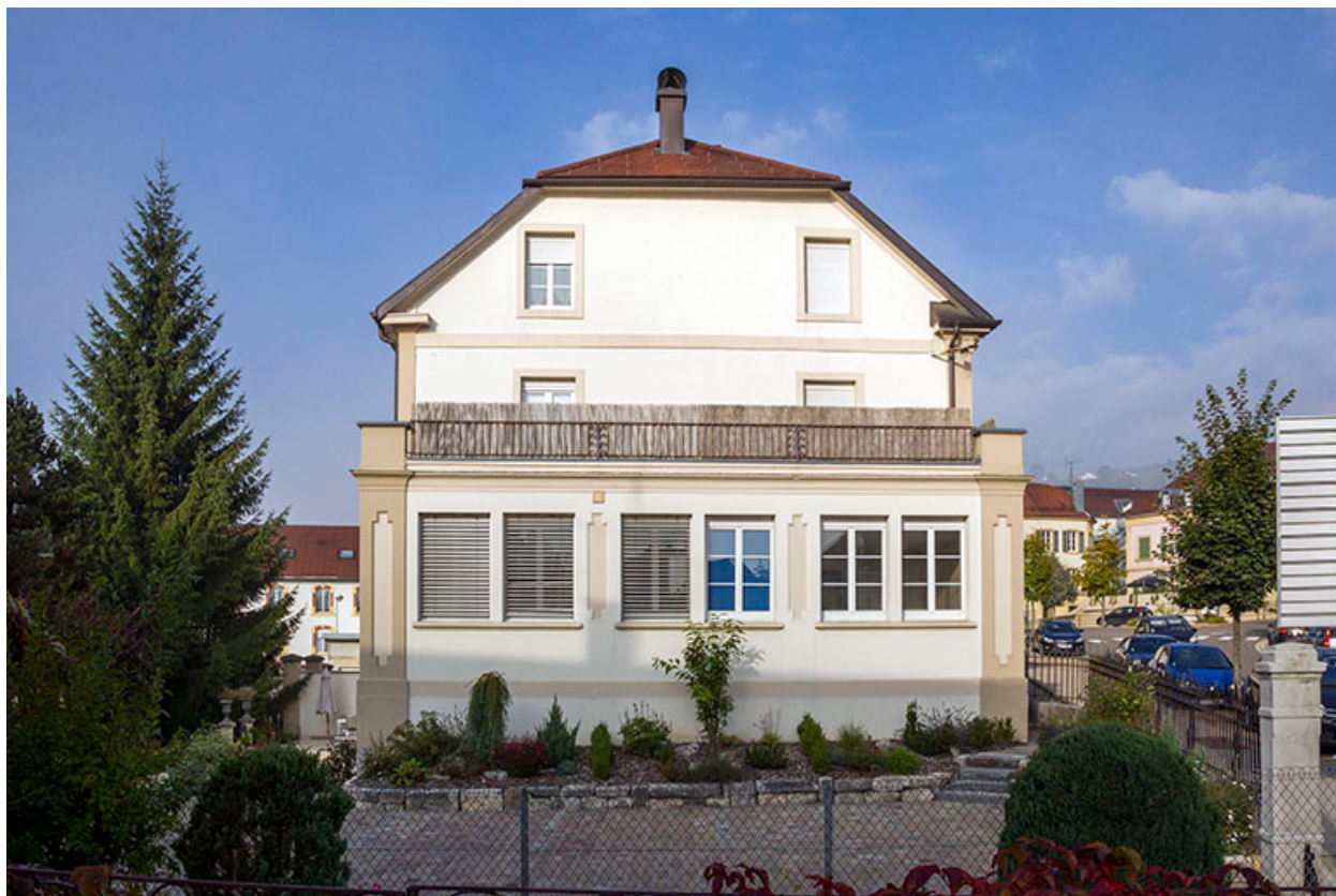
Façade latérale gauche, avec l'atelier.
